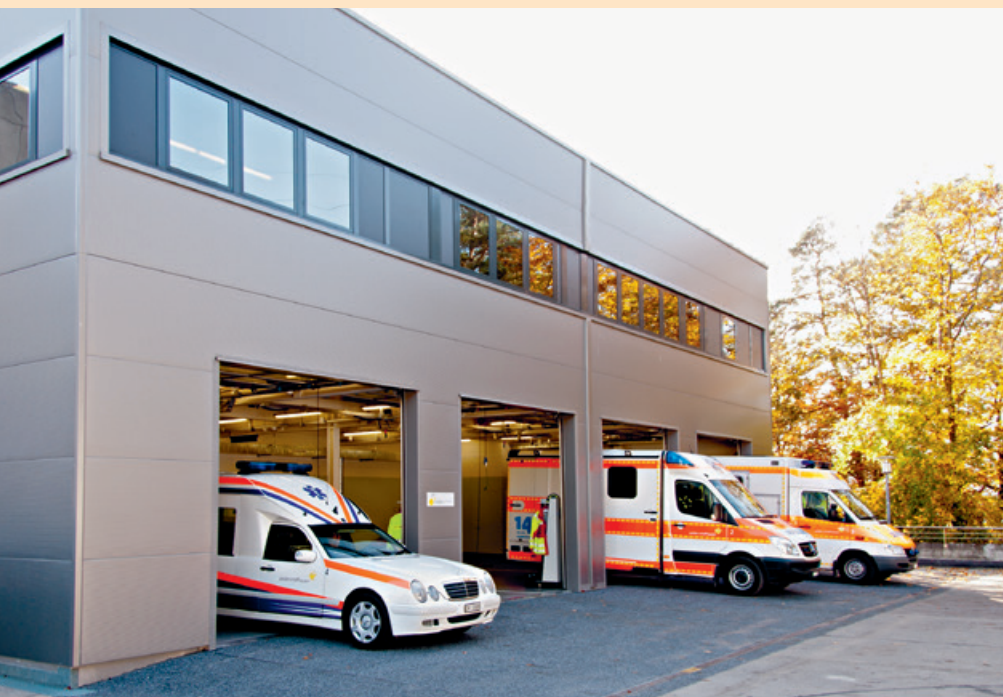
Die Auslagerung des Rettungsdienstes war Voraussetzung für den jetzigen Umbau.
